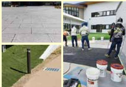
◀カナダで開発された「ストリートプリント」。土に見えるところもアスファルト! 仕上がったアスファルトに熱を加えて型でマス目を入れてペンキで着色! この工法を取り入れることで工事のスケジュールも半分に以下に。
